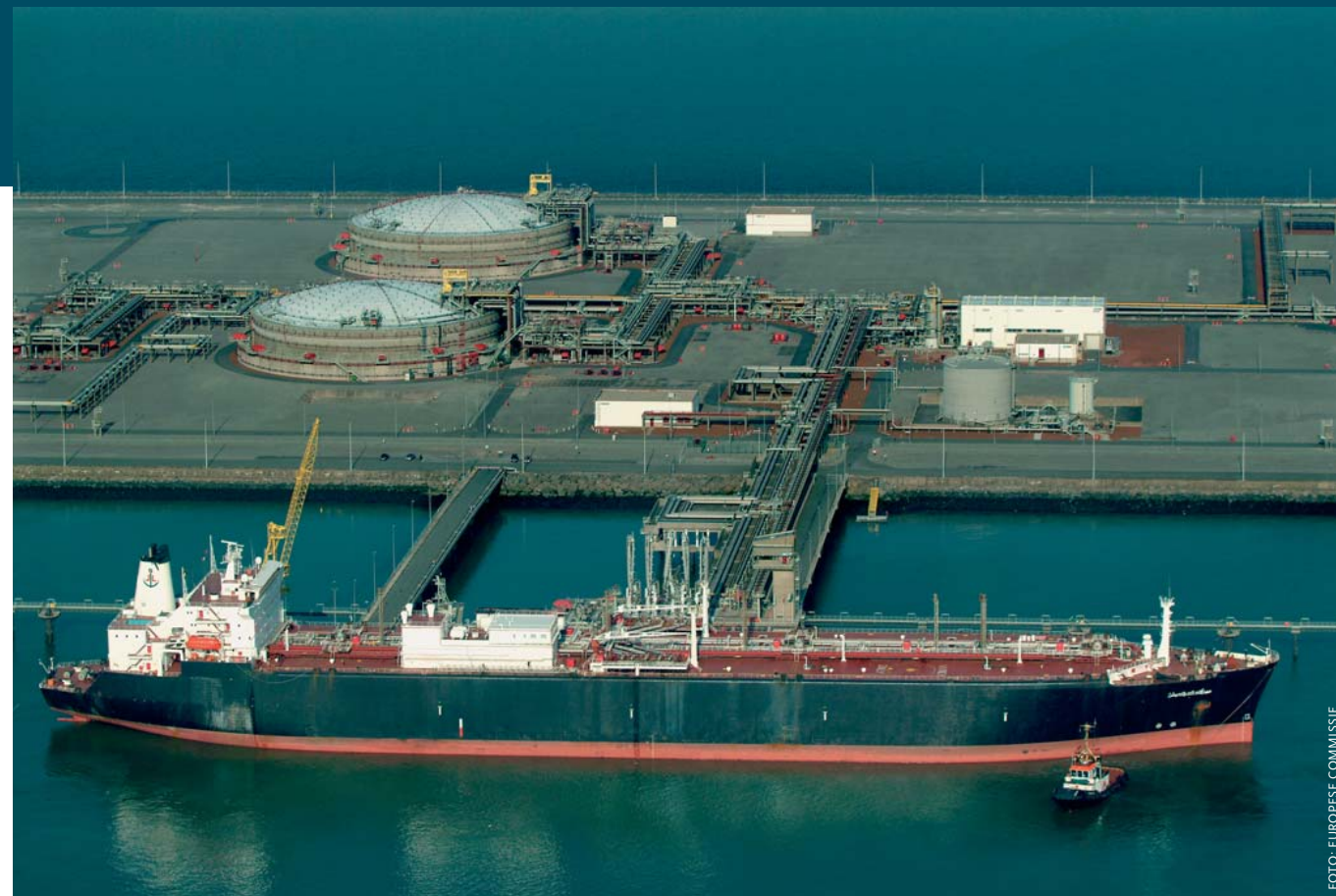
Europa wordt bijna geheel afhankelijk van de aanvoer van buitenlandse olie en gas – zoals hier in de overslaghaven van Zeebrugge.
